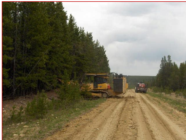
Gambar 2.2. Pembuatan jalan ke Lokasi Pemboran
