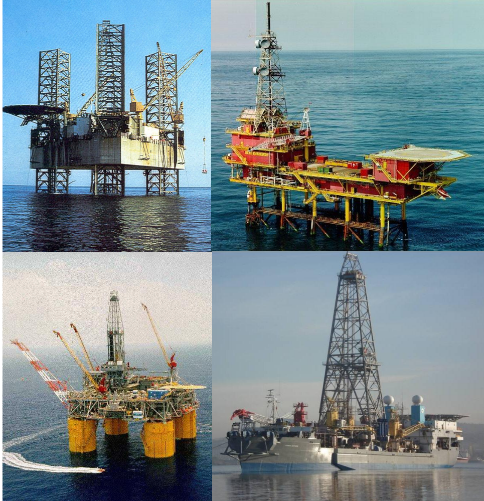
Gambar 4.4. Menara Bor Offshore
