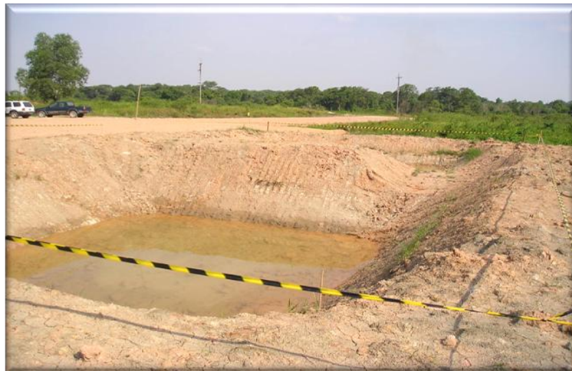
Gambar 2.4. Pembuatan Mud Pit
