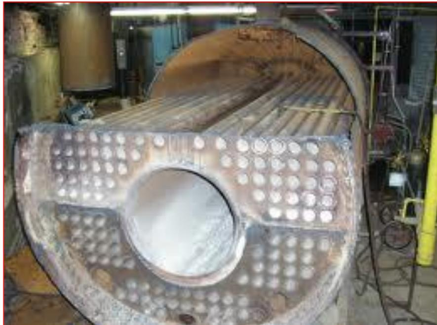
**Gambar 30. Boiler lorong api dengan rangkaian pipa lorong apinya.**
