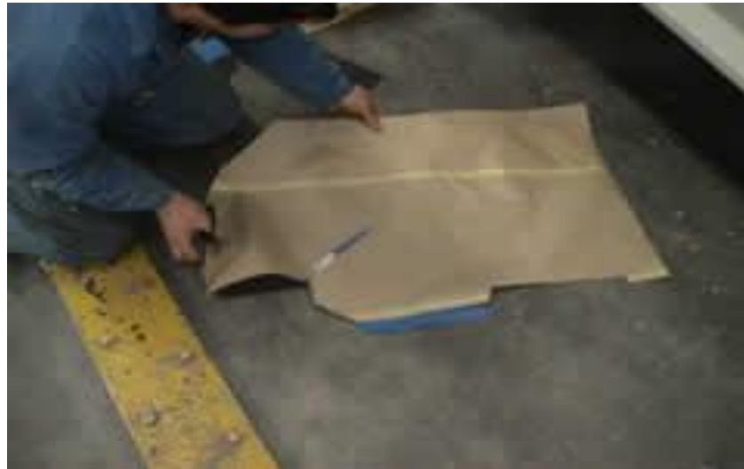
Gb.4.27. Pemotongan lembar peredam suara
