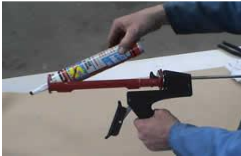
Gb.4.11. Penekanan cartridge sampai sealer keluar dari ujung nozel
