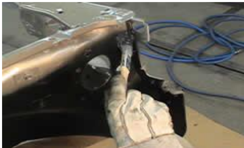
Gb.4.16. Penggunaan kuas untuk melapiskan brush-on sealant
