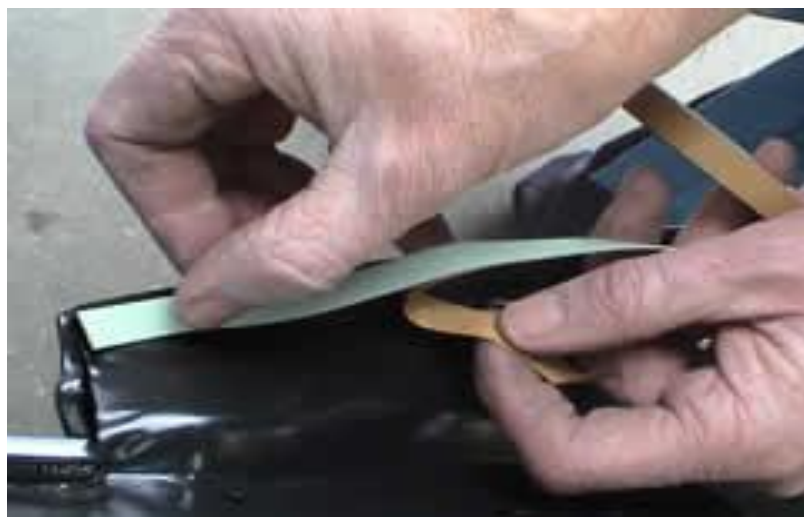
Gb.4.3. Pelepasan sedikit ujung lembar pelindung perekat pada bagian bawah pita
