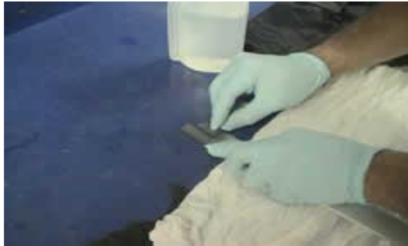
Gb.2.34. Pemotongan dan perapian ujung pita perekat
