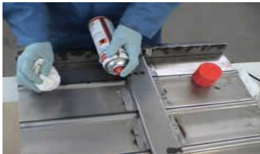
Gb.4.21. Pembersihan area pemasangan dengan semprotan pembersih/solvent
