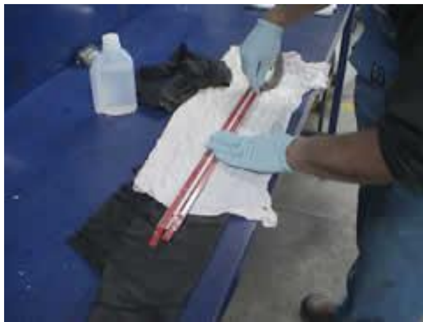
Gb.2.31. Pemasangan pita perekat khusus pada moulding
