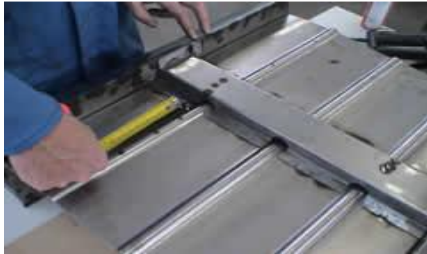
Gb.4.22. Pengukuran area pemasangan
