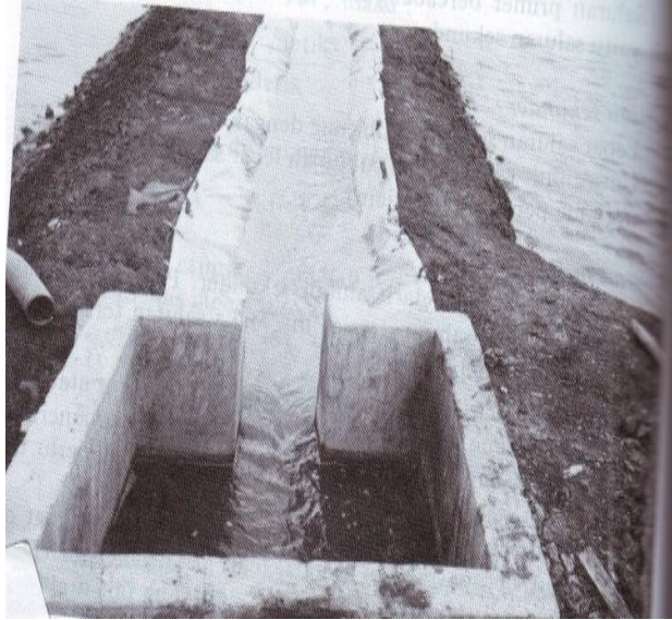
Gambar 15. Saluran pemasok air di atas tanggul dengan saluran tanah yang dilapisi plastik
