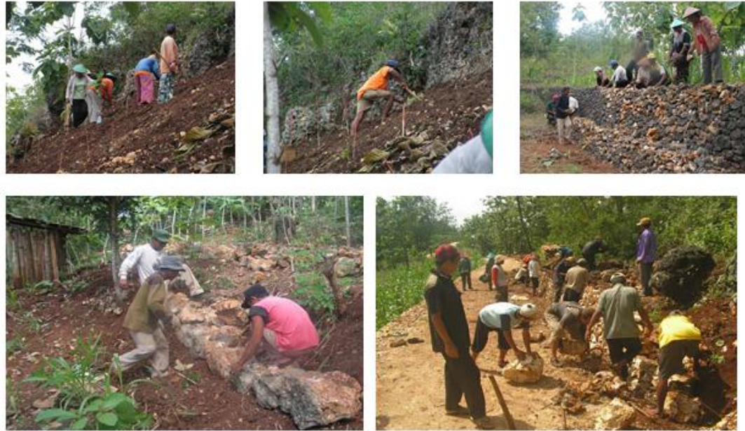
Gambar 21. Pembuatan terasering
