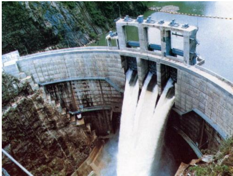
Gambar 23. Bendungan atau dam
