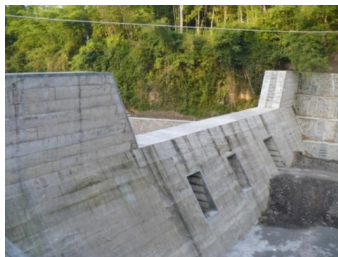
Gambar 39. Bangunan Sabo dam
