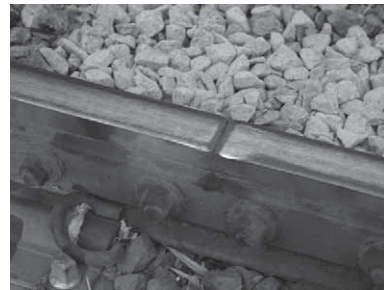
b. Model sambungan pada rel kereta api
