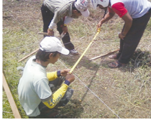
Gambar 5.1 Seorang Tukang sedang mengukur kesikuan lahan
