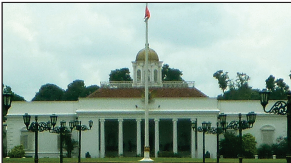
Sumber: Kemendikbud Gambar 2.1 Sebuah bangunan
