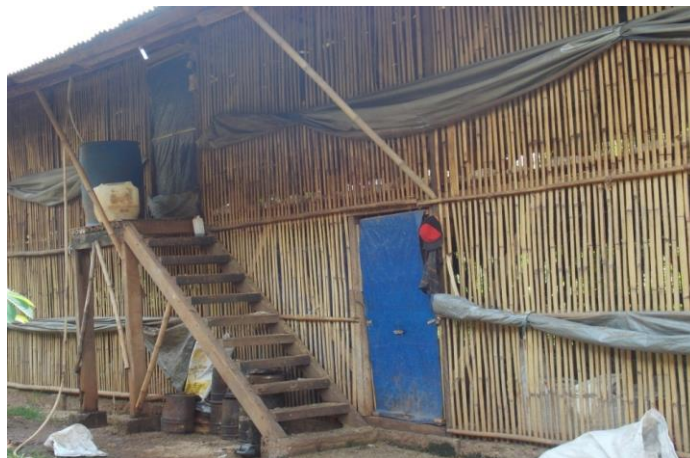
Gambar 9. Dinding kandang bahan dari bambu
