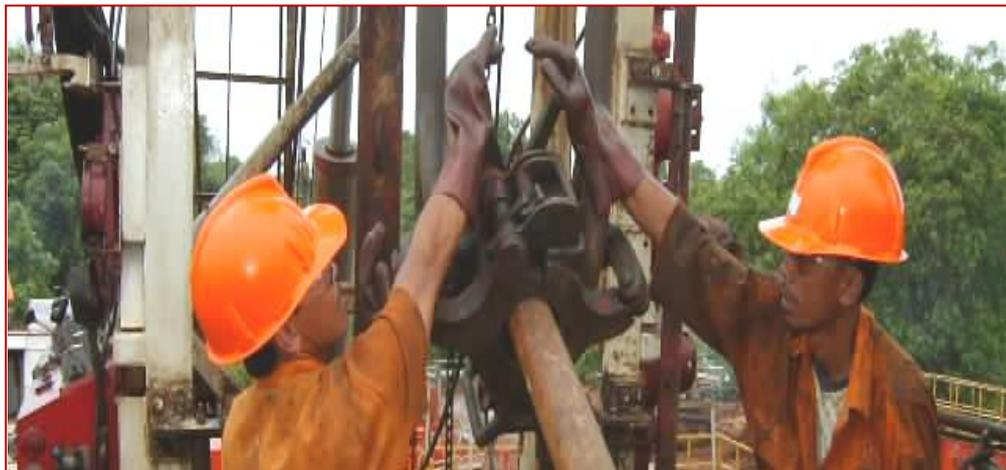
Gambar 5.3 Mengangkat Pipa dari Pipe Rack
