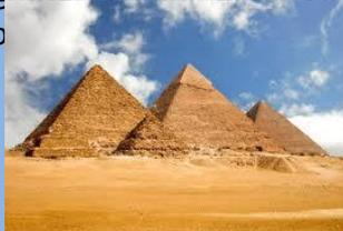
Berdasarkan standar panjang tersebut, bangsa mesir ternyata mampu membangun Pyramid (2750 SM), dengan kesikuan antara sisi bujur sangkar dari dasar pyramid, toleransinya adalah +12 detik, sedangkan panjang masing masing sisi bujursangkarnya yang 230.000mm mempunyai kecermatan +14 mm.
