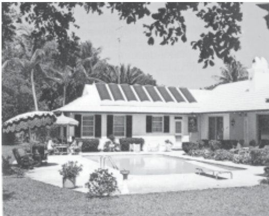
Gambar 8.2 Energi panas matahari digunakan sebagai pemanas air di rumah-rumah
