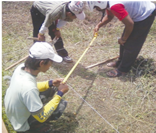
Gambar 5.1 Seorang Tukang sedang mengukur kesikuan lahan
