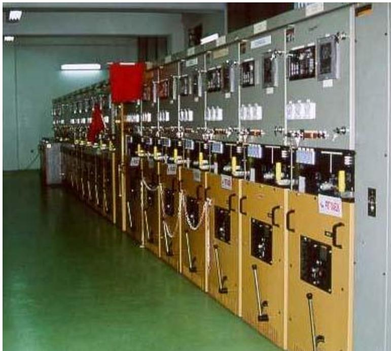
Gambar 3- 14. Cubicle 20 kV.
