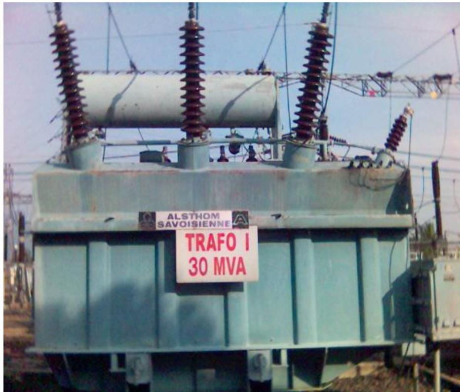
Gambar 3-1. Transformator daya GI Konvensional.
