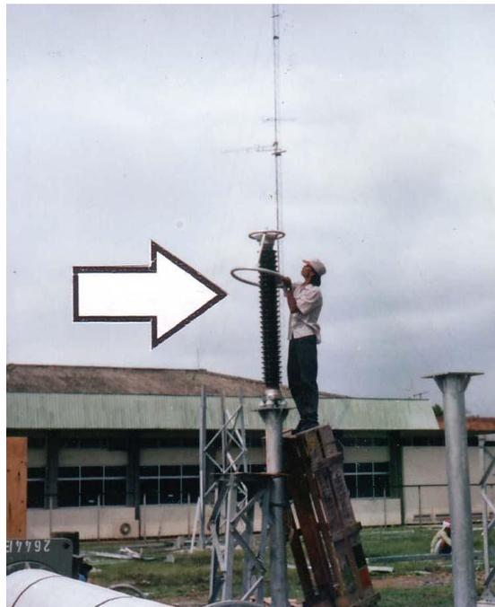
Gambar 3-5. *Lightning Arrester (LA).*
