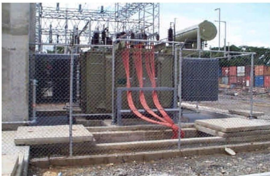
Gambar 4-9. Transformator Distribusi Tiga Phasa.
