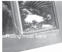
Gambar 6.17 Ruang muai pada pemasangan kaca
