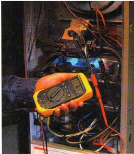
Gambar 8.1 Pengukuran resistansi dengan Multimeter
