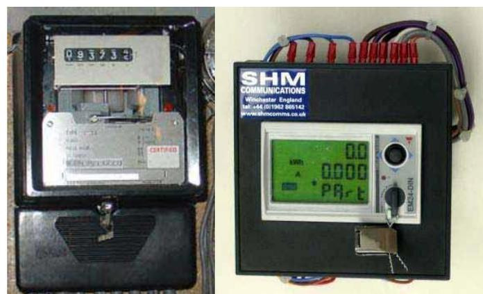
**Gambar 4.58 Kwh meter tiga fasa analog dan digital**
