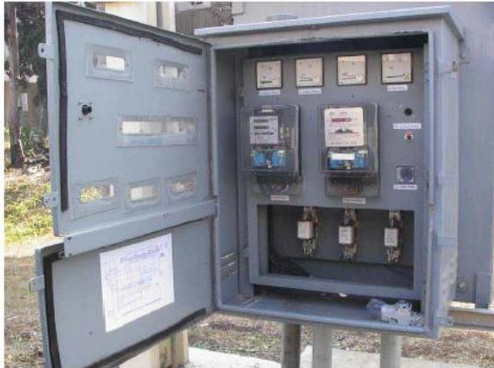
**Gambar 4.59 Kwh meter tiga fasa dan KVARh**
