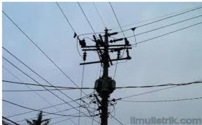
**Gambar 4.25 Jaringan tegangan menengah**
