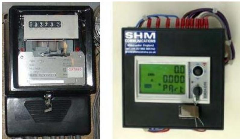
**Gambar 4.27 Alat pembatas dan pengukur**
