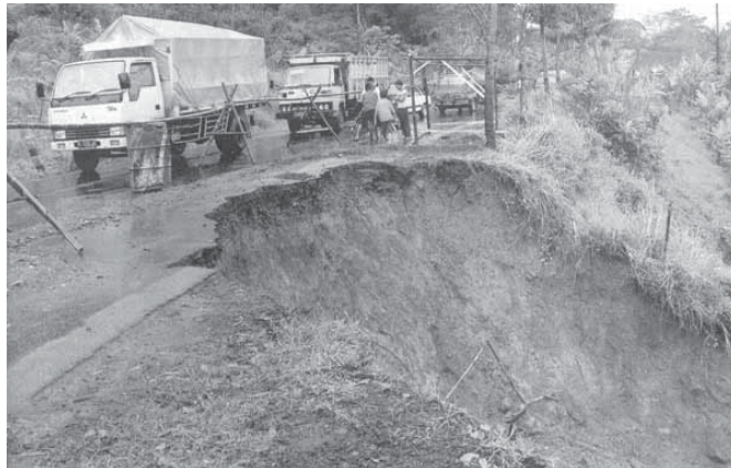
Gambar 1.27 Foto tanah longsor
