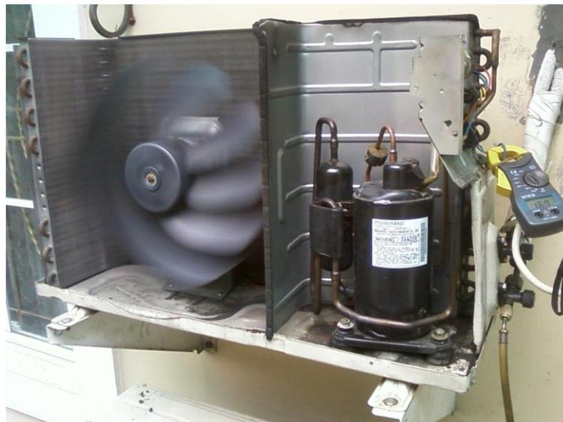
Gambar 2.6 Konfigurasi Komponen Unit Out Door AC Split
