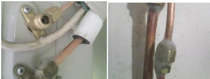
**Gambar 6.10** Pemeriksaan Kebocoran Pada Sambungan Pipa AC *Split*
