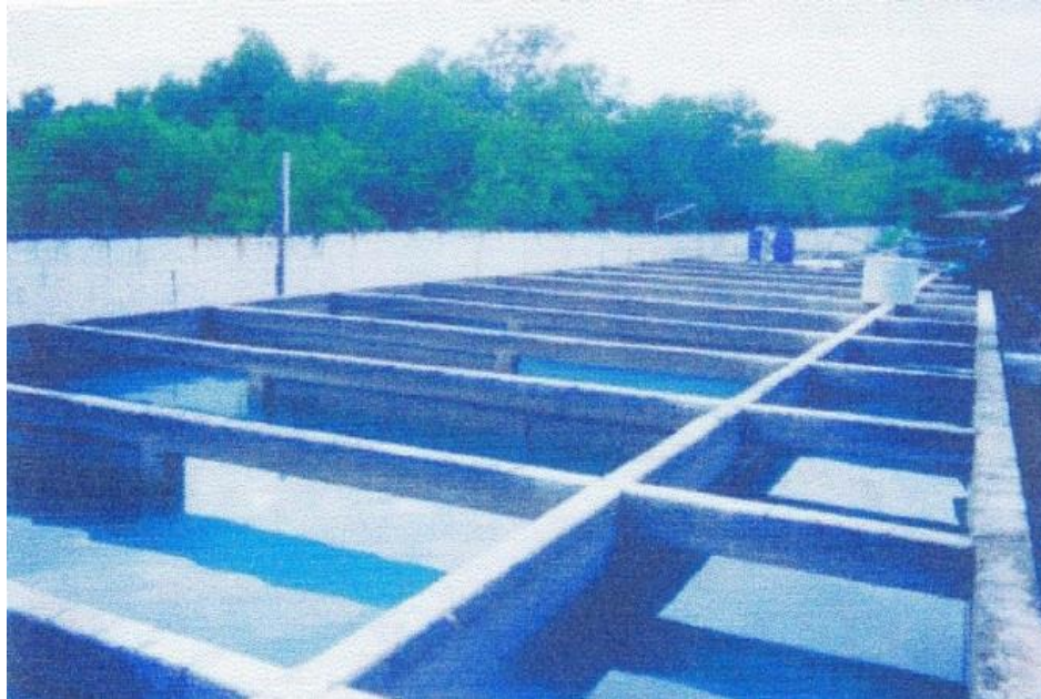
Gambar 13. Bak sedimentasi yang bersekat – sekat
