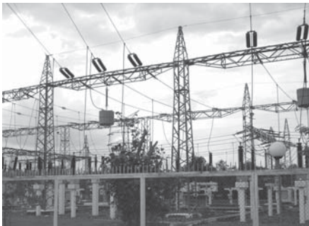
(a) Kabel Listrik
