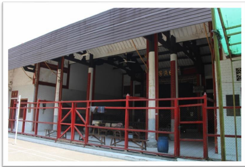
Bagian depan rumah abu Foto: Kecapi Batara
