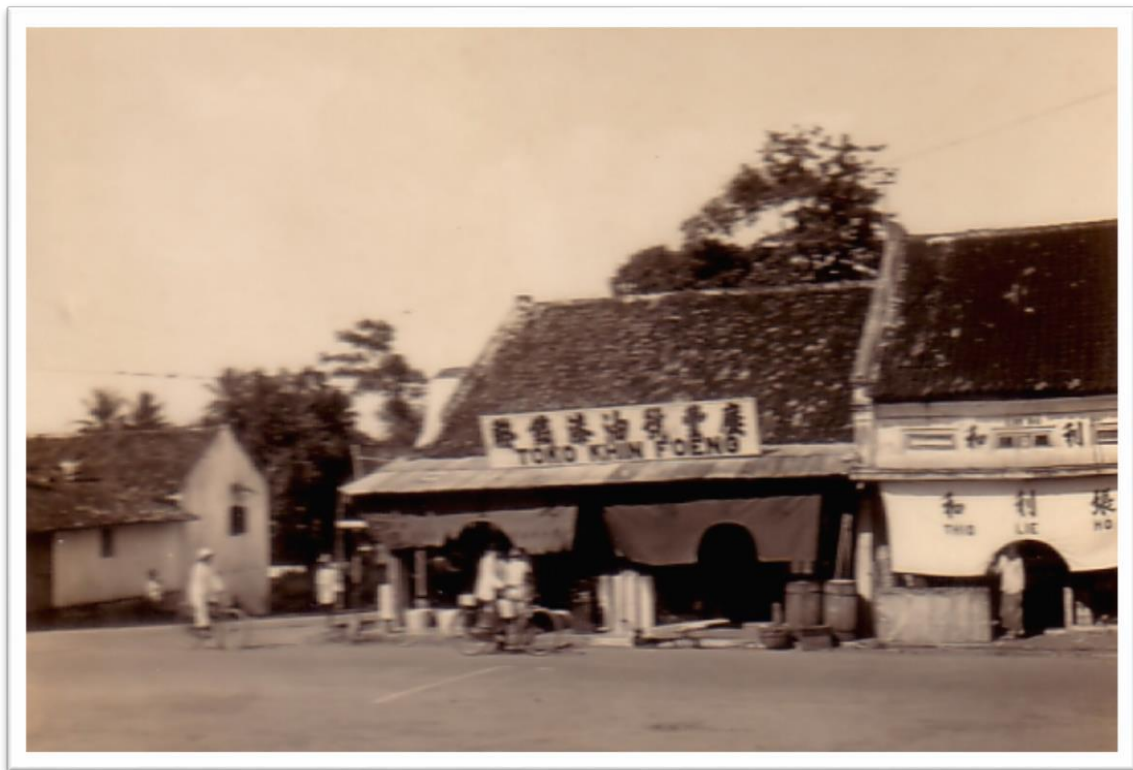
Pasar Tanah Abang Foto: Arsip
