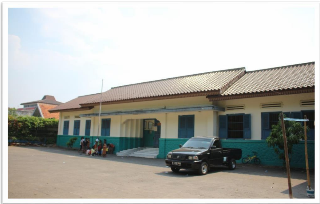
Bangunan SDN 07 Pagi Palmerah, bekas sekolah Tionghoa yang sudah berubah Foto: Kecapi Batara
