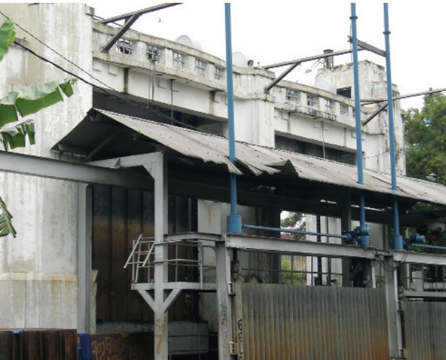
■ Pintu Air Manggarai (2009)
