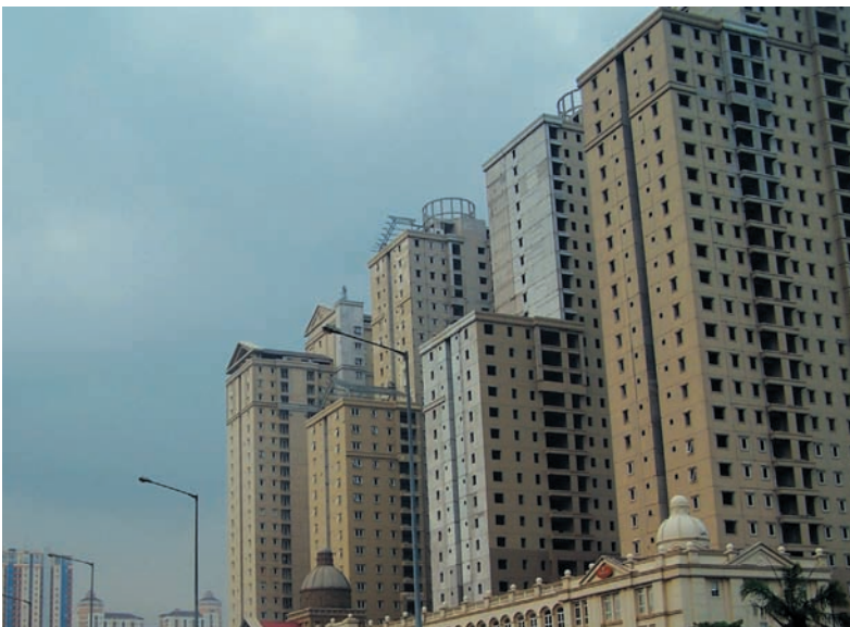
■ Pembangunan apartemen di Kota Baru Kemayoran (2009)
