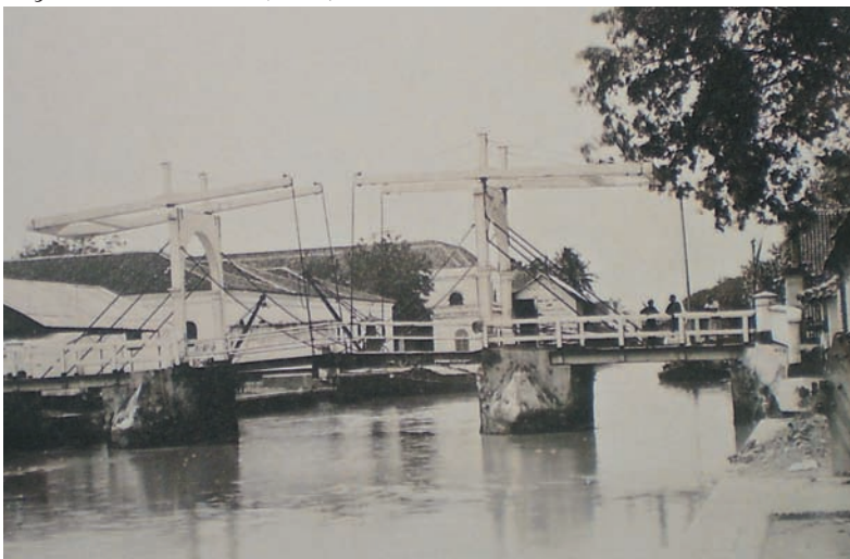
■ Jembatan Kota Intan (1890)
