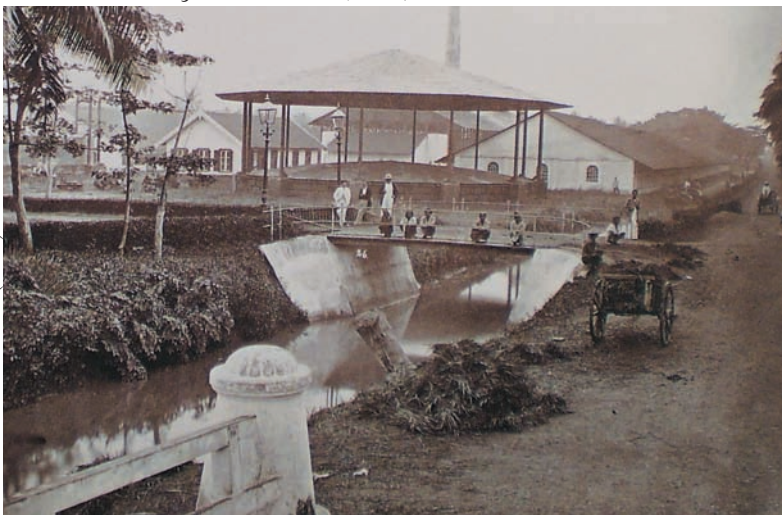
■ Kondisi daerah Jembatan Busuk (1872)
