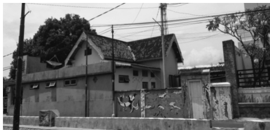
Bangunan Madrasah Moh. Alwi saat ini menjadi rumah salah seorang warga, namun arsitektur rumah di dalam pagar tidak berubah. Sumber: Koleksi Foto Siti Hasanah
