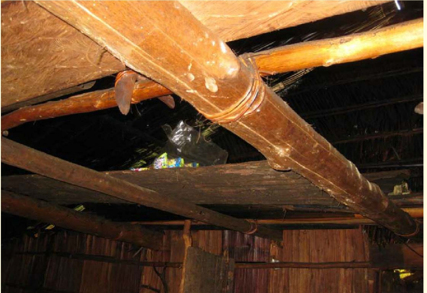
Ikatan Tali sebagai pengikat antar balok kayu sebagai pembentuk konstruksi atap rumah kaki seribu (Dok. Yuke Ardhiati, 2014)
