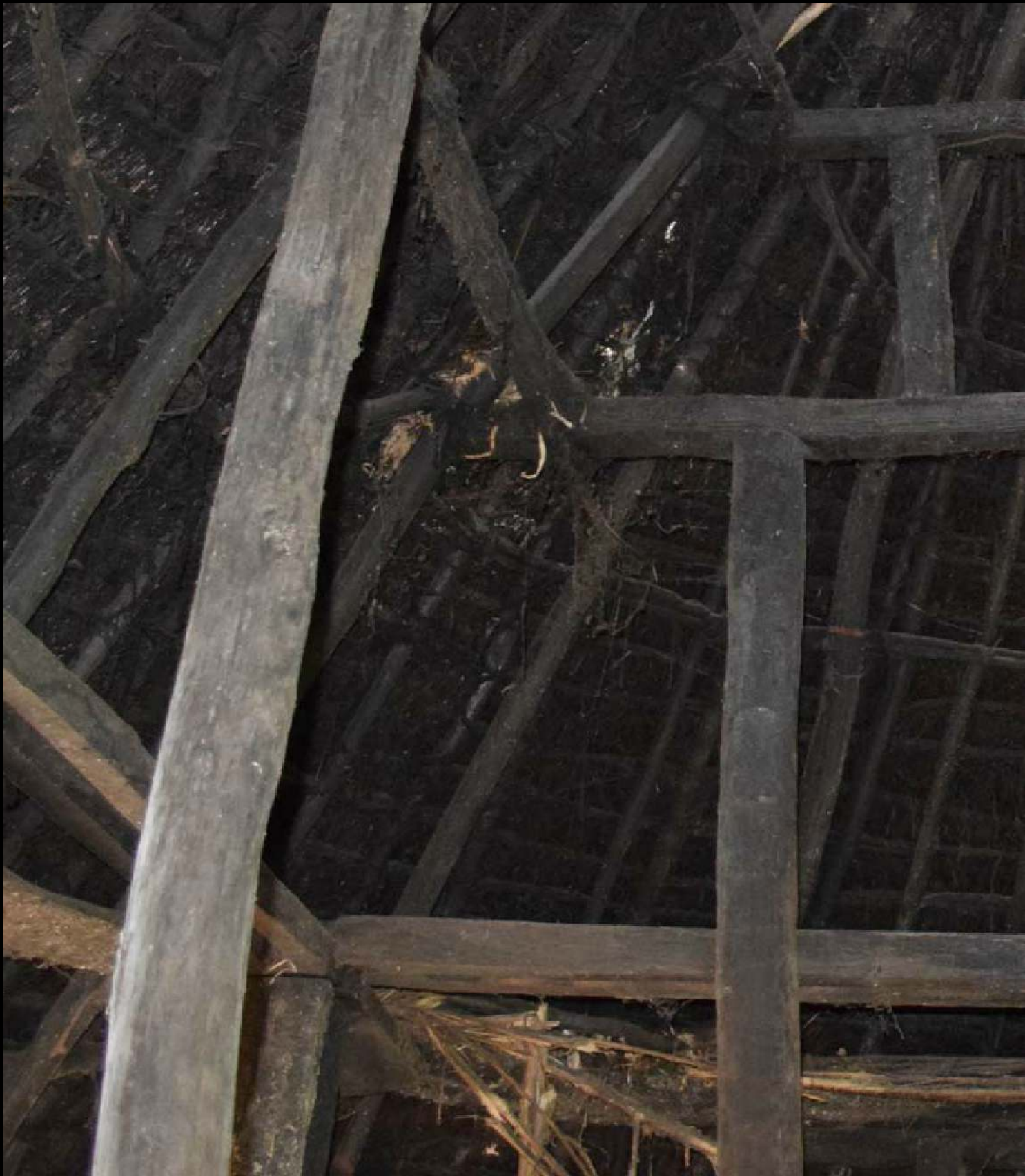
Konstruksi dan Struktur rangka dengan tiang-tiang utama yang berfungsi sebagai penahan beban atap. (Dok. Yuke Ardhiati, 2014)
