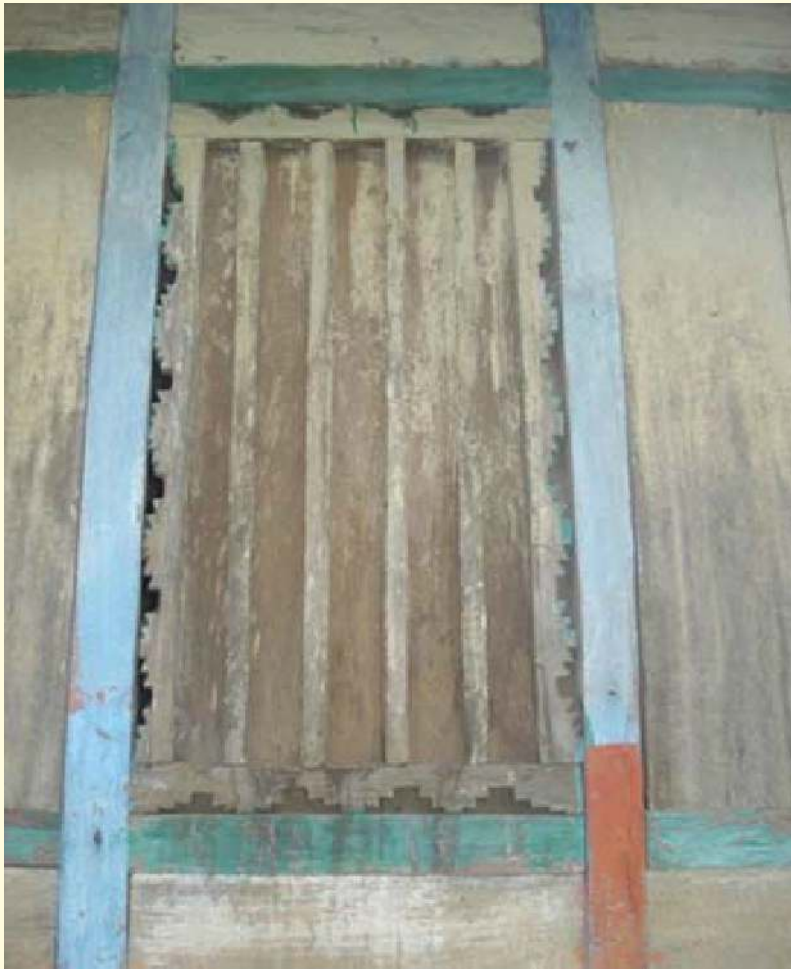
Ragam hias tipe gunung bertuah digunakan pada dinding luar sebagai ventilasi.
