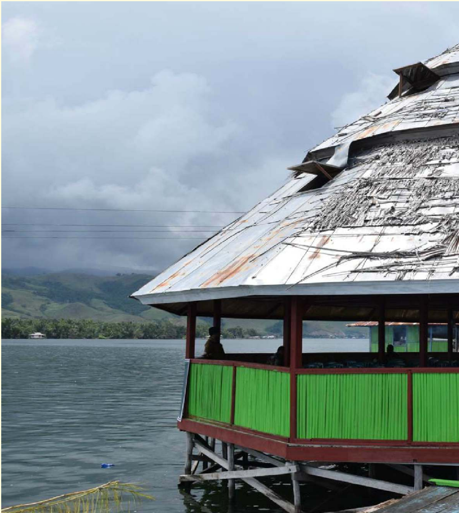
Bangunan Kombo Asei, dibangun di tepi Danau Sentani, Kampung Asei.
