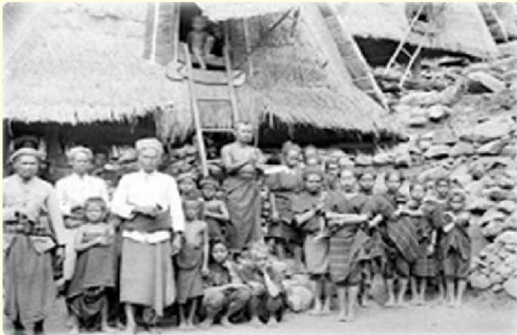
Suku Donggo yang dianggap penduduk asli wilayah Bima dan Dompu dengan latar rumah lengge pada masa lampau.
