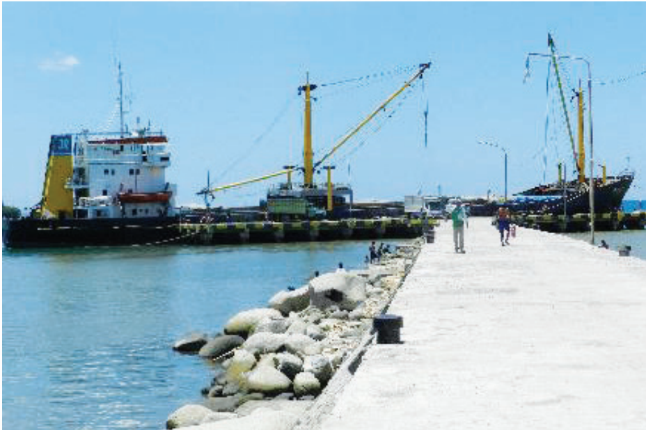
Gambar 6.1.5 Kondisi Dermaga Labuh Kapal di Pelabuhan Tilamuta Sumber: dokumen penulis, Maret 2016
